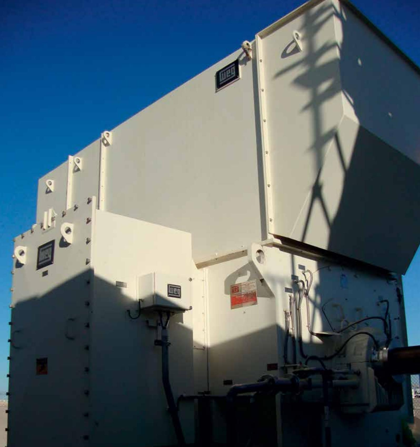
**Energie-Riese: Der Generator von WEG in Nakhla hat eine Leistung von 10,2 MVA und wiegt rund 36 Tonnen.**
